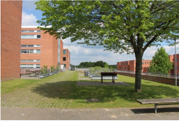
Bygningerne ligger på et plateau i niveau med Chr. M. Østergaardsvej, der afsluttes i en mur, der optager terrænspringet mod det lavere liggende terræn mod øst.
