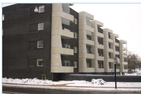
Figur 26. Eksempel på altaner, der er afskærmet mod støjkilden (her en vej) og åbne i den modsatte retning.
