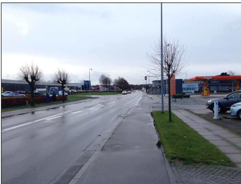
Figur 8.3-7 Høegh Guldbergs Gade set mod nord (nord for Ove Jensens Allé).
