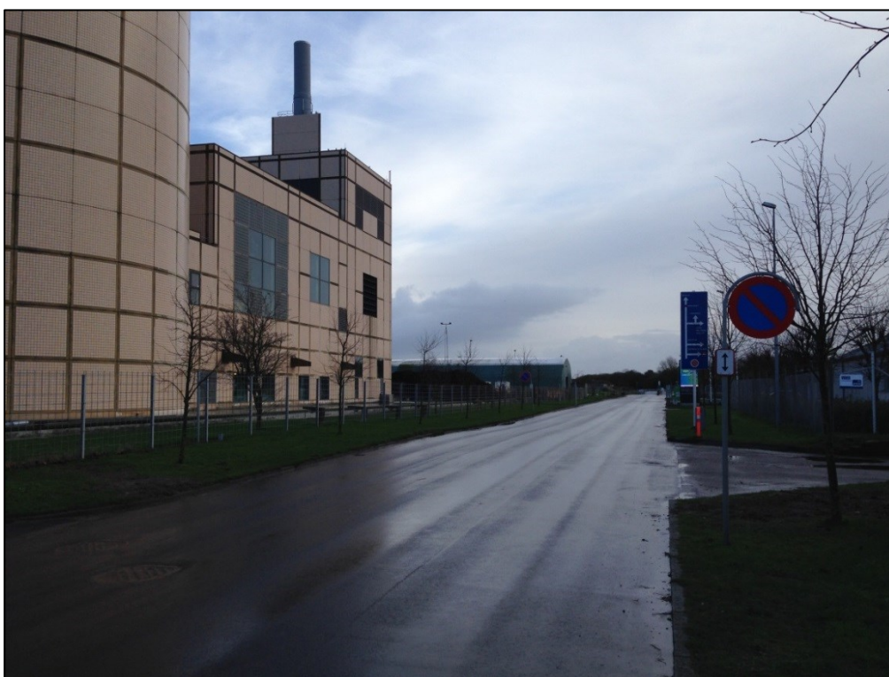
Figur 8.3-10 Endelavevej set mod øst (genbrugsstation til højre)
