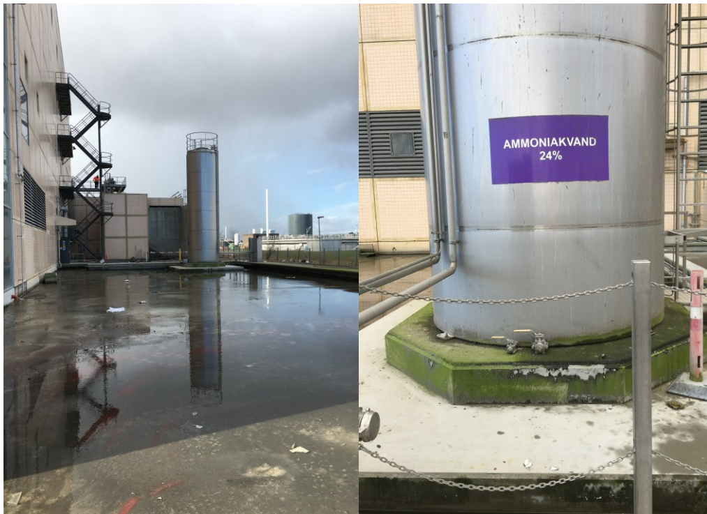
Figur 4.3-10 Eksisterende ammoniaktank er placeret nord for kraftvarmeværket
