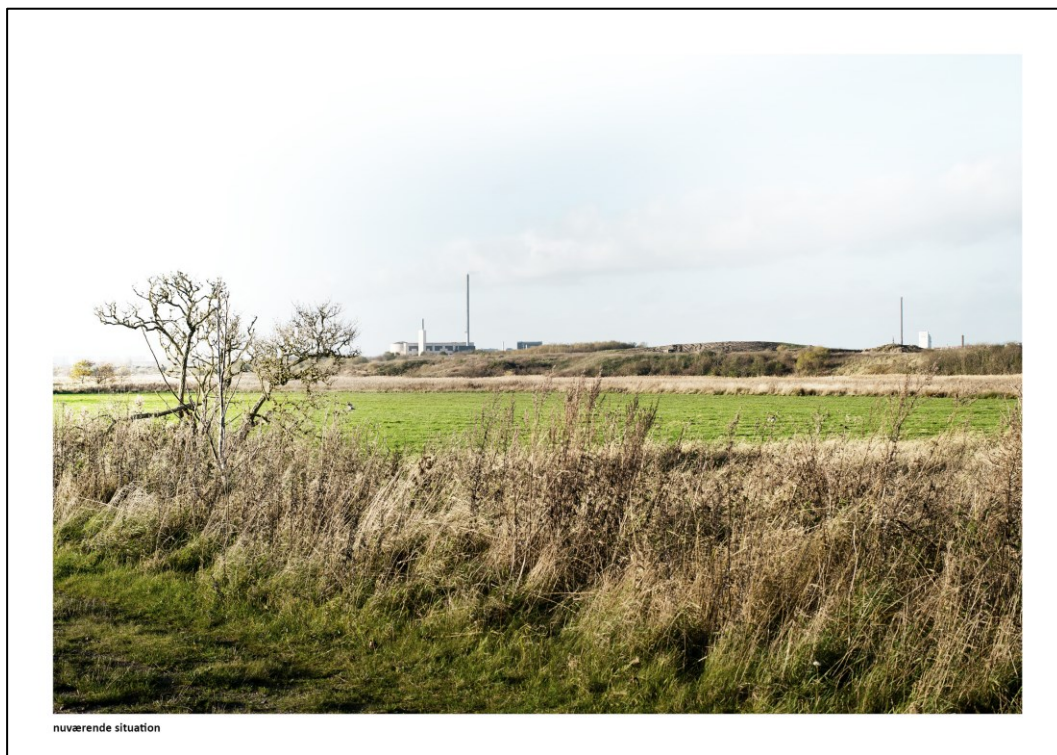
Figur 8.9-31 Fotostandpunkt nr. 8 – Eksisterende kraftvarmeværk set fra sydøst på Bollerstien.
