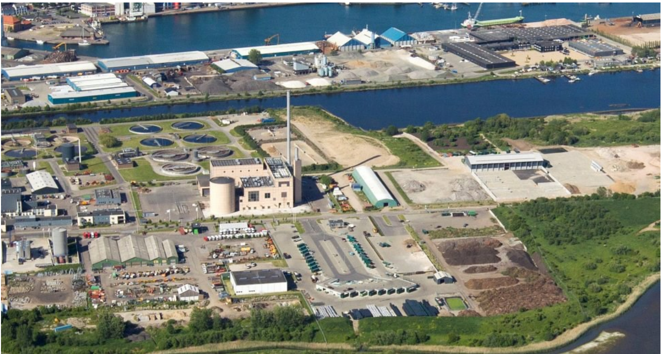
Kraftvarmeværket på Endelavevej set fra syd, med Rensningsanlægget og Erhvervshavnen i baggrunden.
