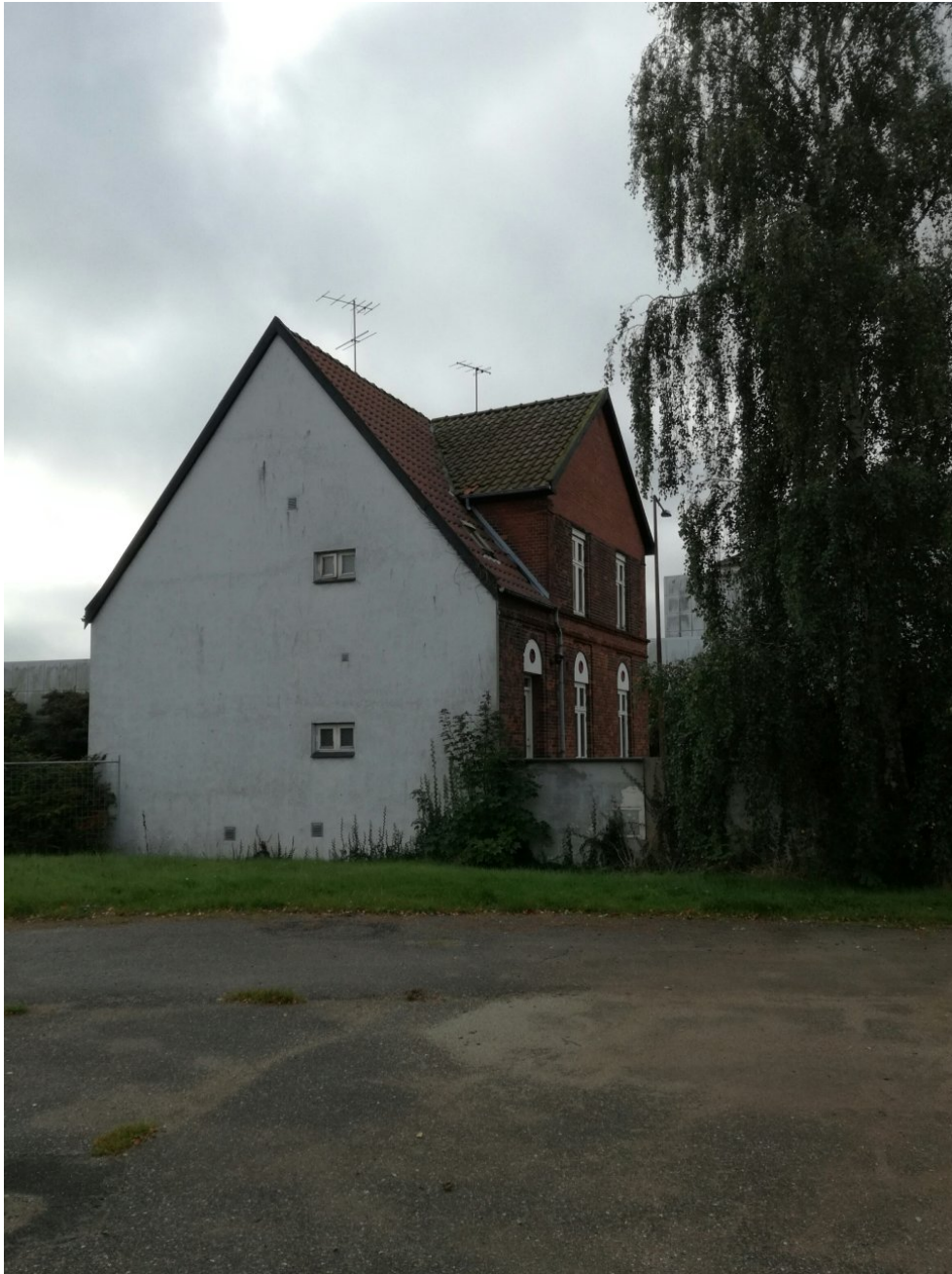
Ny Havnegade 72 fra 1914. Ny Havnegade 72 fungerer i dag som privat bolig. Bygningen skal vedligeholdes og bevares efter lokalplanens bestemmelser. Ny Havnegade 72 kan indgå i et samlet boligprojekt indenfor delområde 2.
