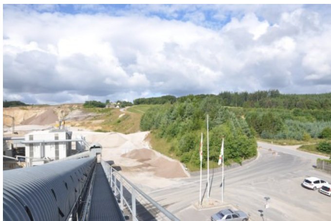
Indkørsel fra Lervejdal, hvor mod der er etableret støjvold.
