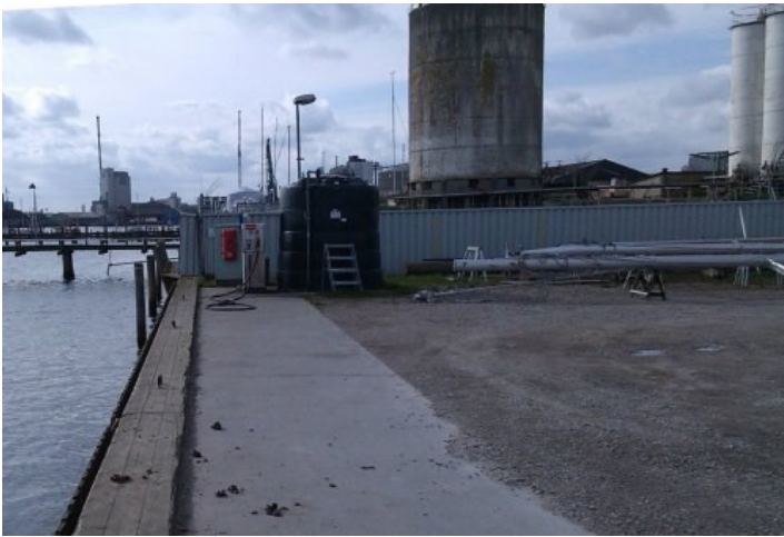
Havnefronten set mod øst fra den eksisterende servicekaj. Lokalplanområdet ligger bag indhegningerne. Der er ikke mulighed for offentlig passage langs havnebassinet.
