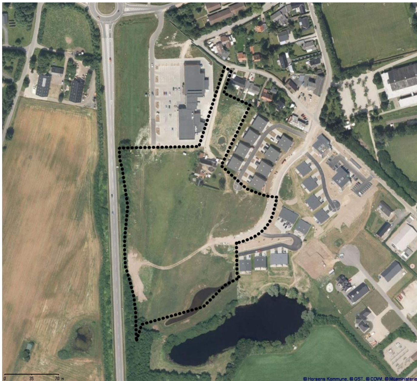
Luftfoto, eksisterende forhold med Lokalplanafgrænsning
