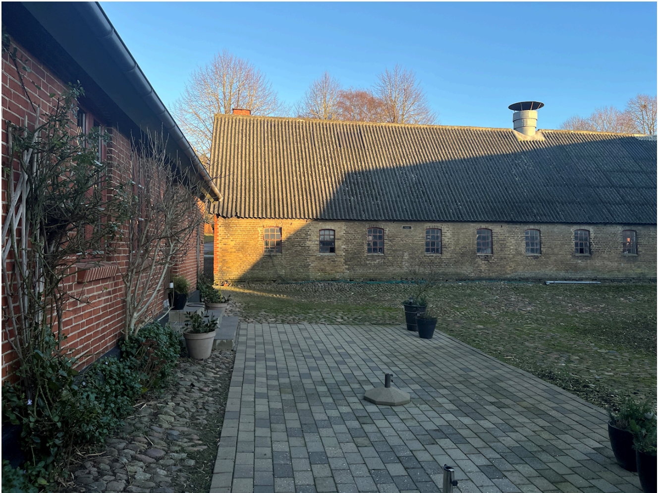
Stald / driftsbygninger på ejendommen som nedrives
