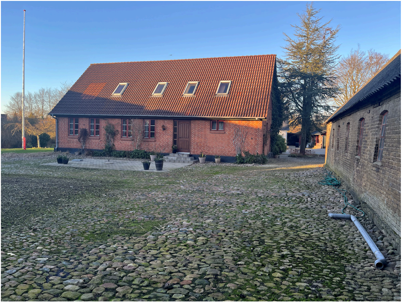
Stuehus på ejendommen som bevares
