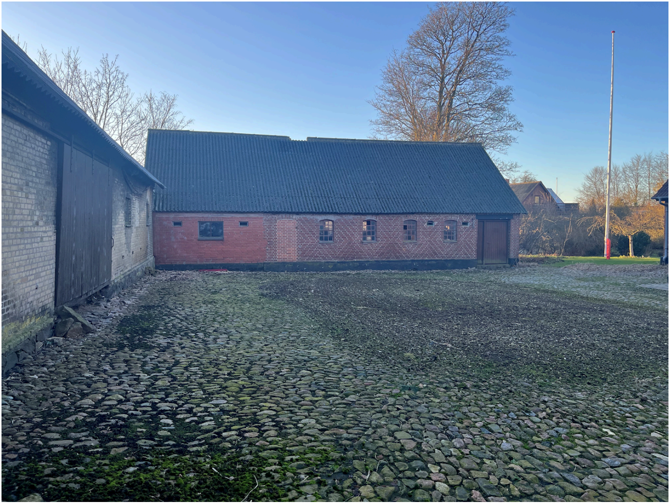
Stald / driftsbygninger på ejendommen som nedrives
