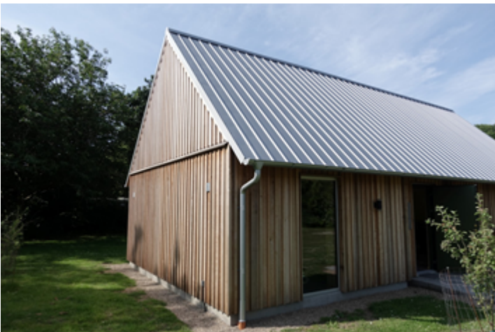
Eksempel på ståltag kombineret med facader i træ (foto Linjen arkitekter)
