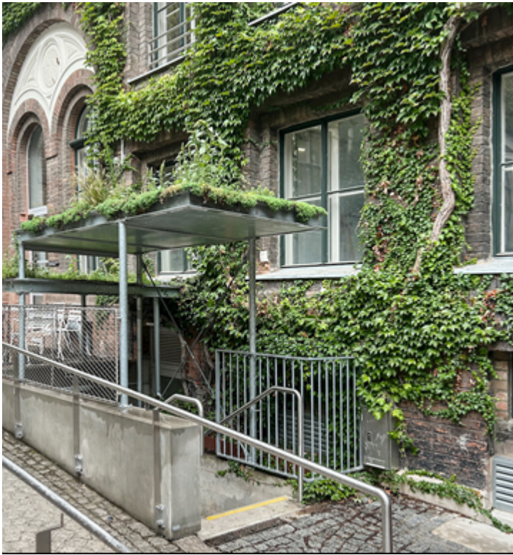
Eksempel på kombineret stål og begrønnet tag (foto Linjen arkitekter)
