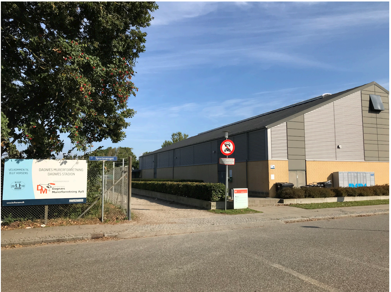
Eksisterende forhold set fra Sportsvænget.
