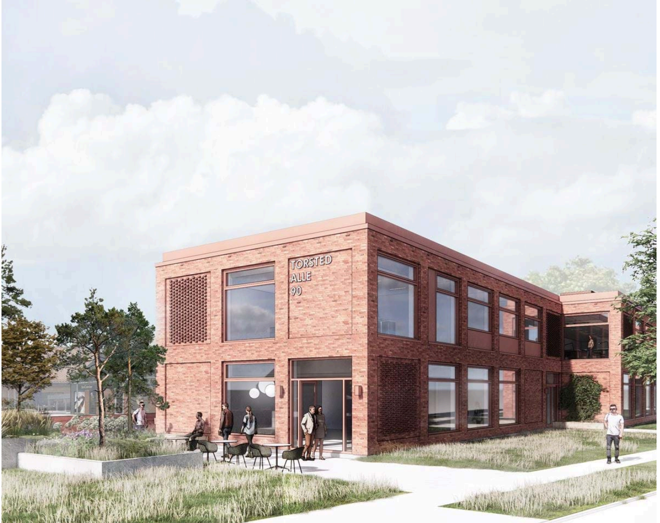
Sydlig facade med publikumsorienterede funktioner og skiltning på gavl
