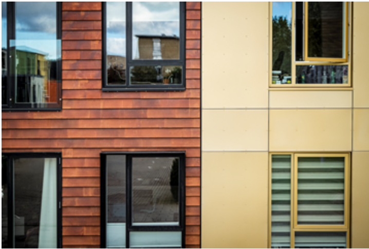
Princip for facadebeklædning og mødet mellem materialer
