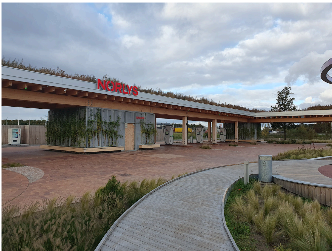
Referencebillede - Anlæg med ladestandere, Odense.
