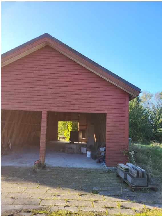
Figur 2.12: Bygning 3, set fra nord
