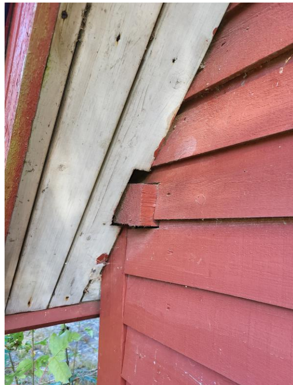
Figur 2.13: Bygning 4, indflyvningshulhed i den sydlige gavl.
