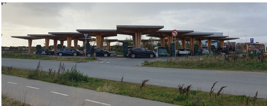
Figur 40 Referencefoto, der viser ladestandere med overdækkede trækonstruktioner.
