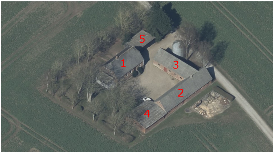
Figur 30 Skråfoto fra 2023 /64/. De røde tal markerer bygningsnumre jf. BBR.
