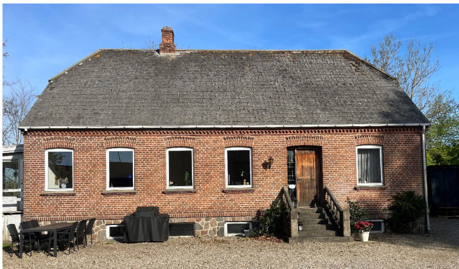
Figur 32 Billede fra besigtigelse d. 29. april 2025. Stuehusets facade.
