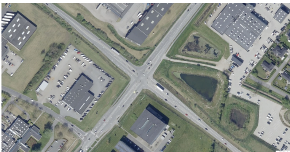
Figur 6-2 Luftfoto af krydset Vejlevej/Ringvej Syd.
