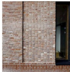
Detaljeret murværk, forsætninger i murværket
