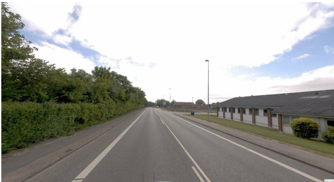
Område til pladskrævende varegrupper vist i retning af Riingvejen (mod øst). En grøn buffer fastholdes mod Hattingvej. Området er bebygget, og det visuelle udtryk er reguleret af lokalplan 380 og den gældende lokalplan 150 (skiltning langs indfaldsveje).
