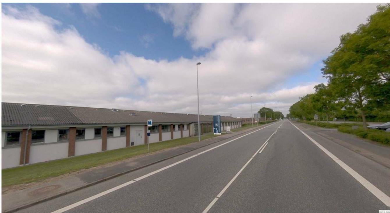
Område til pladskrævende varegrupper set fra Hattingvej mod vest. En grøn buffer fastholdes mod Hattingvej. Området er bebygget, og det visuelle udtryk er reguleret af lokalplan 380 og den gældende lokalplan 150 (skiltning langs indfaldsveje).
