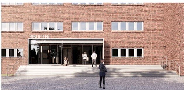
Trappe-rampeanlæg ved sydlig hovedindgang - galvaniseret stål - gitter og rørprofiler, håndliste i træ
