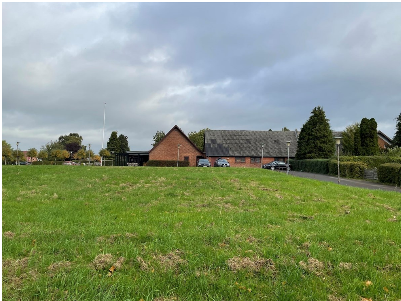
Erhvervsejendommen nord for lokalplanområdet.
