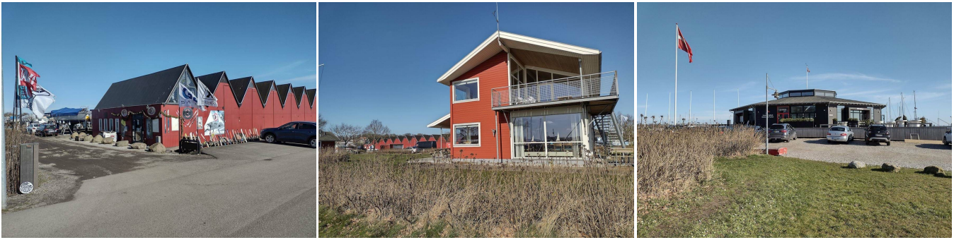
Bygninger og deres materialer i området i dag.
