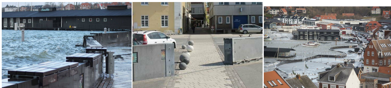
Reference på sikring mod højvand i Lemvig. Løsningen giver mulighed for at åbne op og lukke i. Det sikrer at højvand holdes tilbage og at skybrudsvand kan løbe væk fra baglandet, der har en lavere kote end de 1,8 DVR90.
