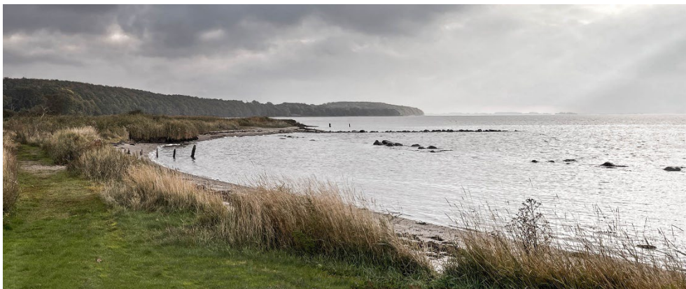
Erosion ved Husodde. På billedet ses en ikke vedligeholdt kystbeskyttelse og erosion af den bagvedliggende kyst.
