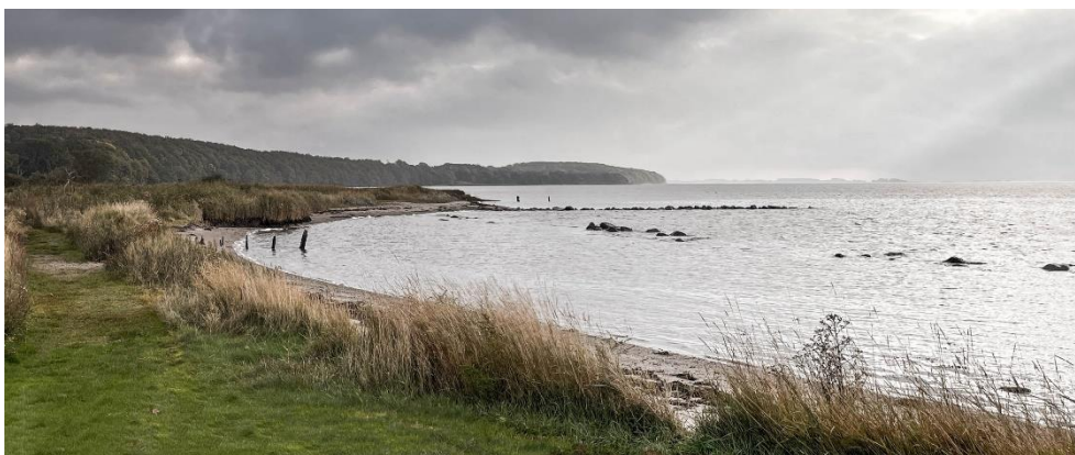
Erosion ved Husodde. På billedet ses en ikke vedligeholdt kystbeskyttelse og erosion af den bagvedliggende kyst.
