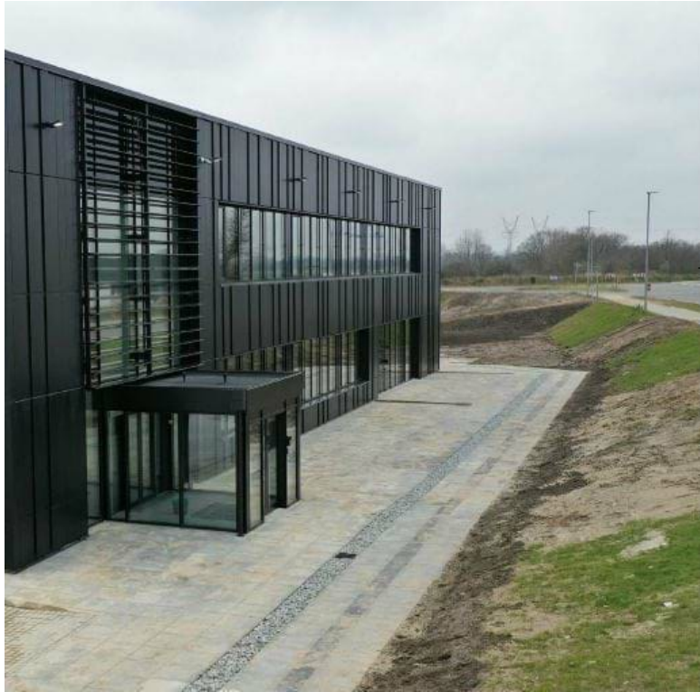
Reference billede for facade på administration
