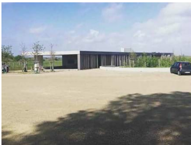
Parkeringsplads i grus i en varm farve.
