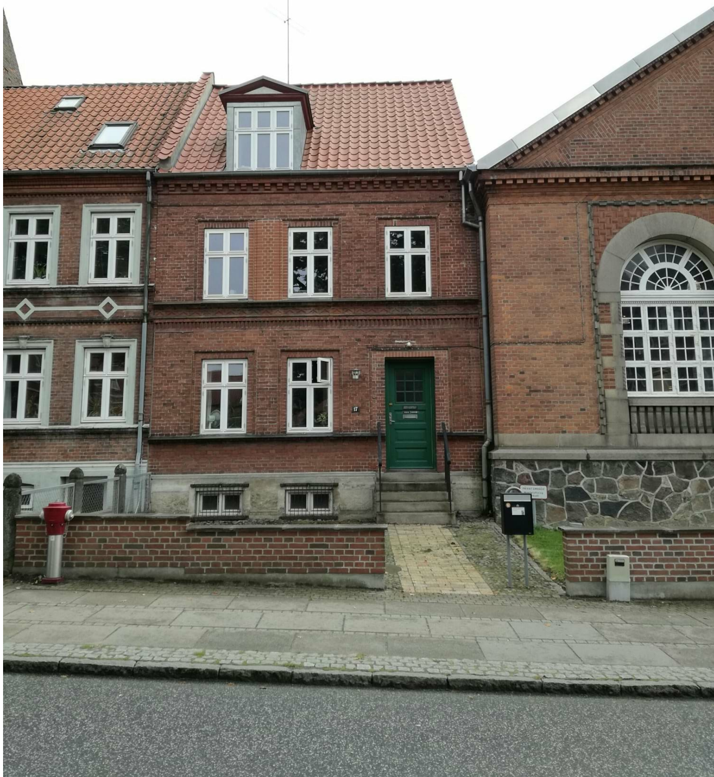
Gasvej 17 skal bevares og vedligeholdes efter lokalplanens bestemmelser.
