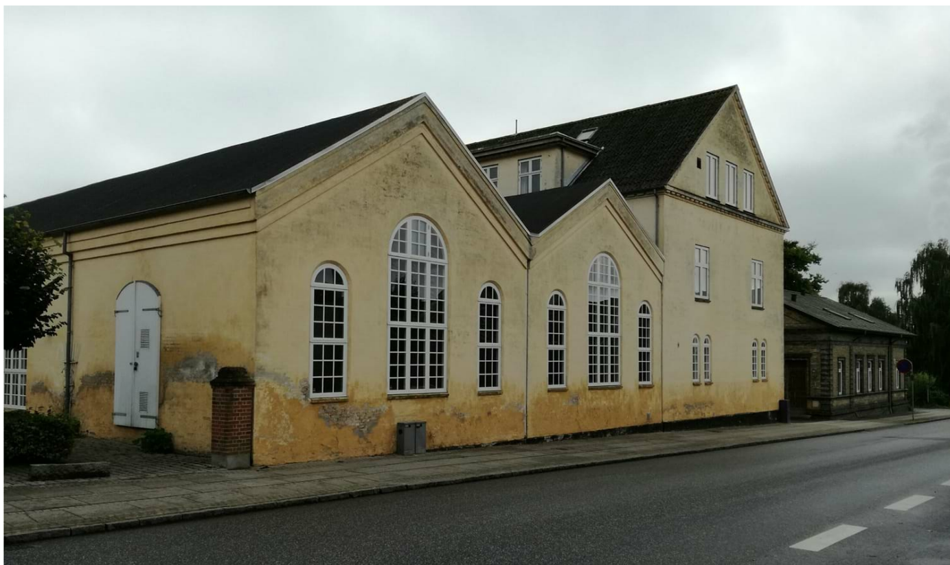
Gasvej 21 De tidligere Gasværks kontorbygninger (Norns grå bygninger). Bygningerne skal bevares og vedligeholdes efter lokalplanens bestemmelser.
