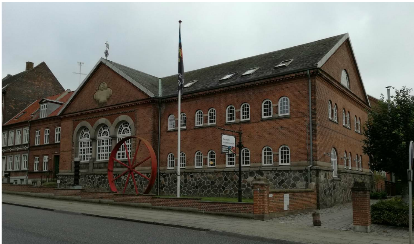
Gasvej 17-19 Industrimuseets hovedbygning fra 1906. Bygningerne skal bevares og vedligeholdes efter lokalplanens bestemmelser.
