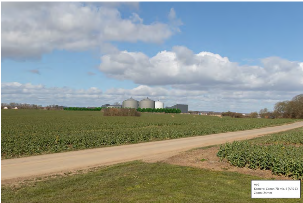
Figur 2-2: Visualiseringspunkt 2 fra Ålkærgårdvej 2 mod biogasanlægget - Udvidelse med seks ekstra reaktorer, antracitgrå reaktorbeklædning og beplantning (VP2-5b).
