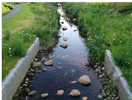
Eksempel på grøft med sten i bunden og naturlig vegetation og eksempel på grøft/lavning med klippet græs.
