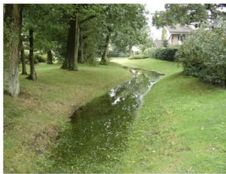
Eksempel på grøft med sten i bunden og naturlig vegetation og eksempel på grøft/lavning med klippet græs.
